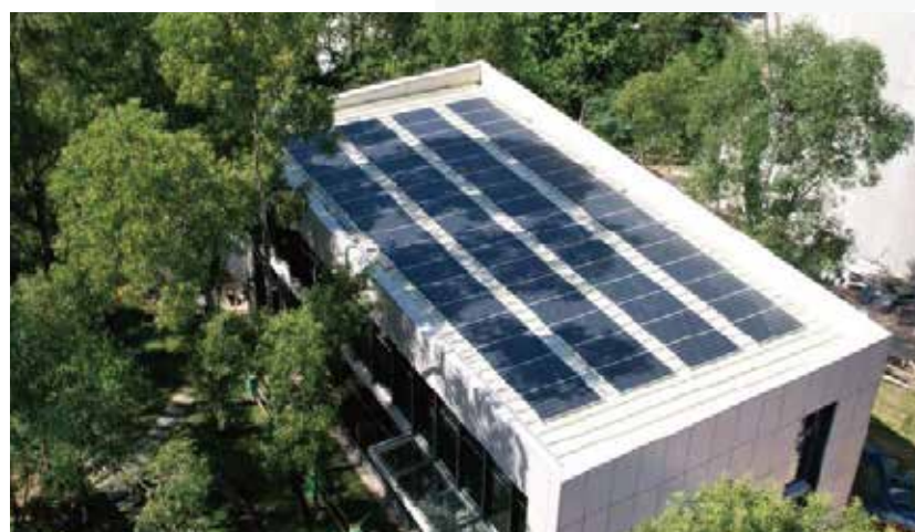
香港有机资源回收中心 二期BIPV展厅
